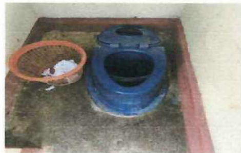
Foto No. 3: Cambio de sanitarios y accesorios EODP ANEXA A EORM AIDA MARTÍNEZ San José la Colonia, Cobán, A.V.
