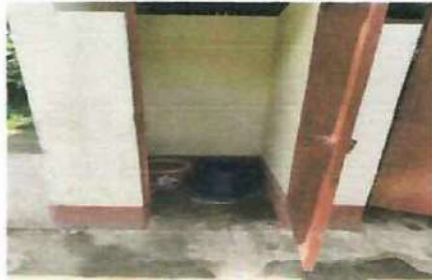
Foto 3: Cambio de sanitarios y accesorios EODP ANEXA A EORM AIDA MARTÍNEZ San José la Colonia, Cobán, A.V.
