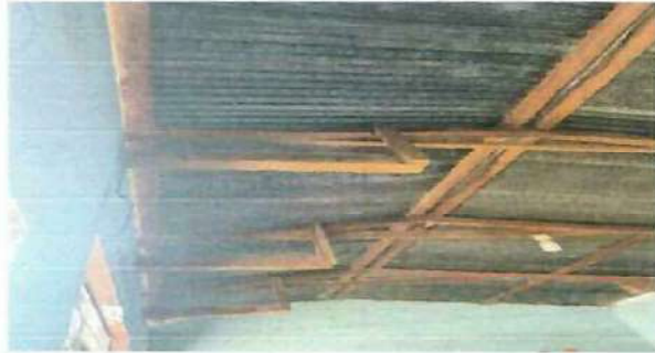
Foto 1: Cambio de estructura de techo EODP ANEXA A EORM AIDA MARTÍNEZ San José la Colonia, Cobán, A.V.
