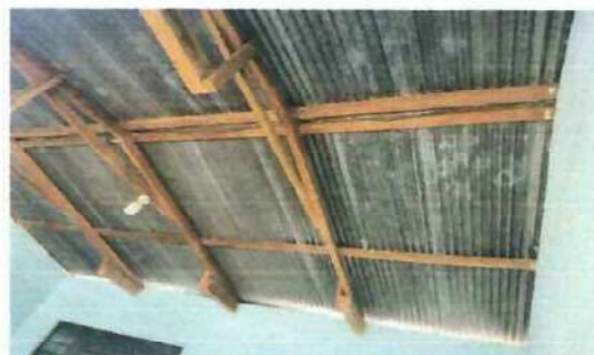
Foto 2: Cambio de estructura de techo EODP ANEXA A EORM AIDA MARTÍNEZ San José la Colonia, Cobán, A.V.
